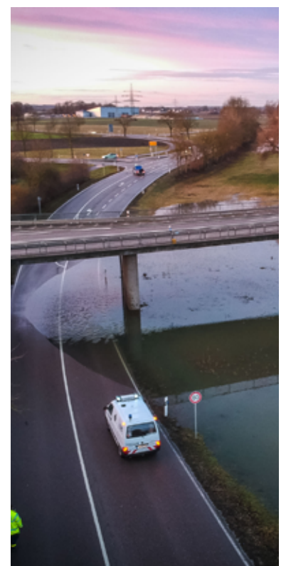
Das THW-Donauwörth im Einsatz mit dem mobilen Hochwassergegel. Foto: THW/Sebastian Birzele
