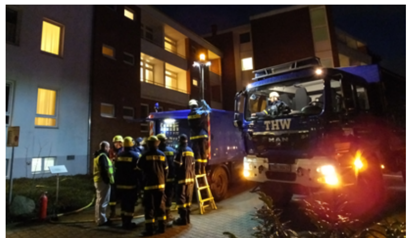
THW-Kräfte der FGr Elektroversorgung versorgen ein Krankenhaus mit Strom. Zukünftig wird auch die FGr N mit NEA in einer Größenordnung um 50 kVA Strom einspeisen können.
