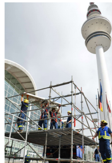
Gerüstbau am Messezentrum.
