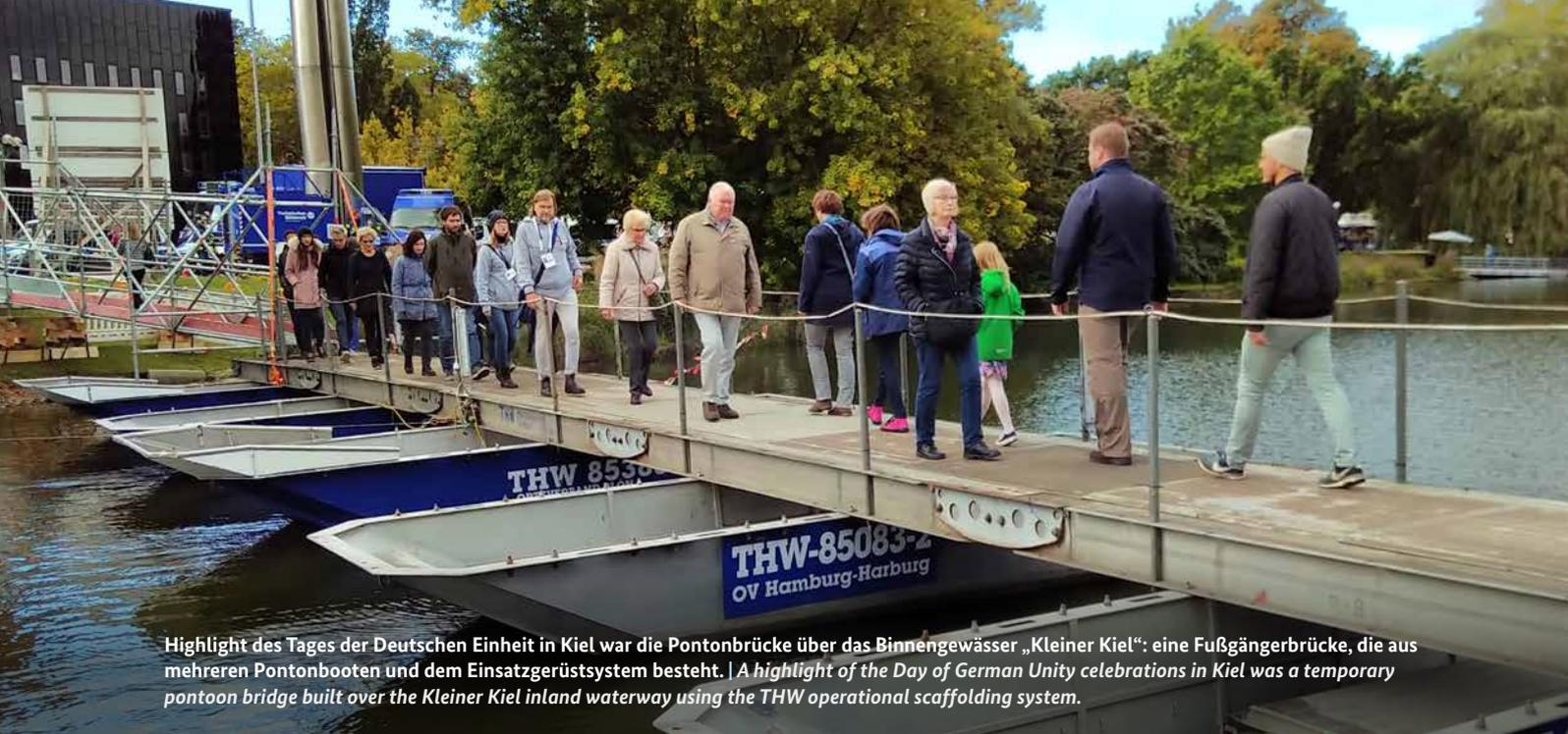
Highlight des Tages der Deutschen Einheit in Kiel war die Pontonbrücke über das Binnengewässer „Kleiner Kiel“: eine Fußgängerbrücke, die aus mehreren Pontonbooten und dem Einsatzgerüstsystem besteht. | A highlight of the Day of German Unity celebrations in Kiel was a temporary pontoon bridge built over the Kleiner Kiel inland waterway using the THW operational scaffolding system.
